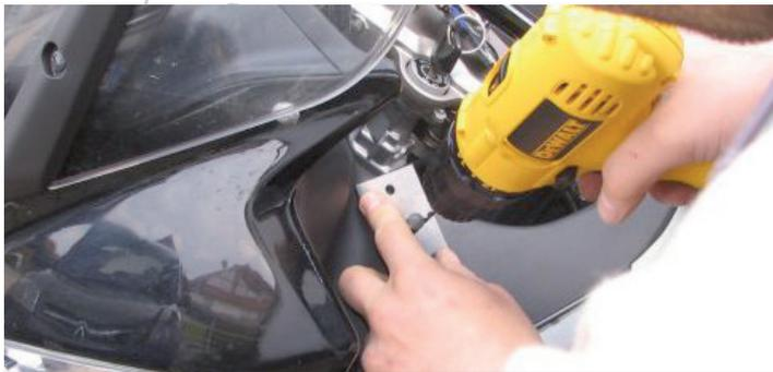
Image 9 Percer les trous avec le gabarit de perçage
